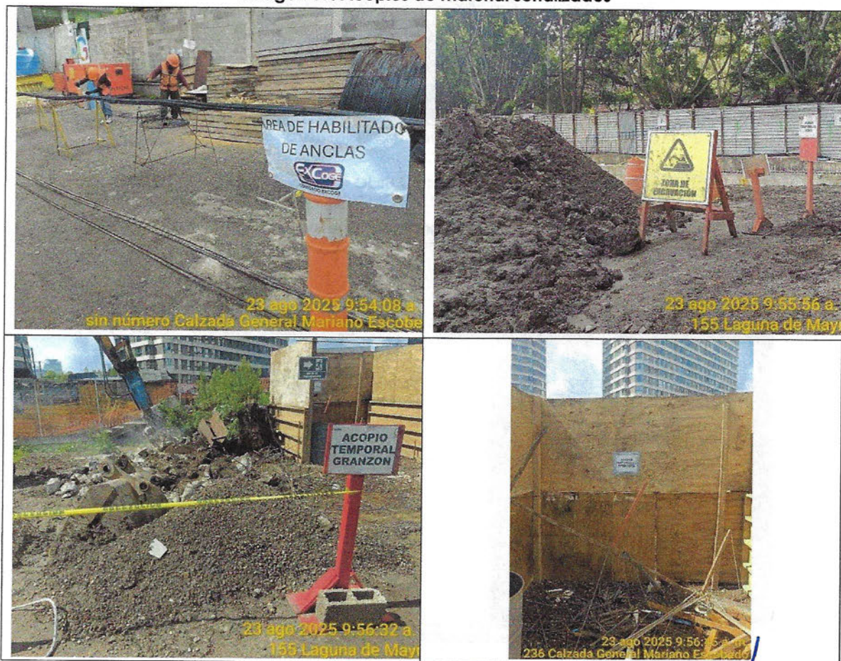
Imagen 17. Acopios de material señalizados
