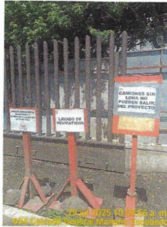
Imagen 16. Señalética de lavado de neumáticos y salida de camiones
